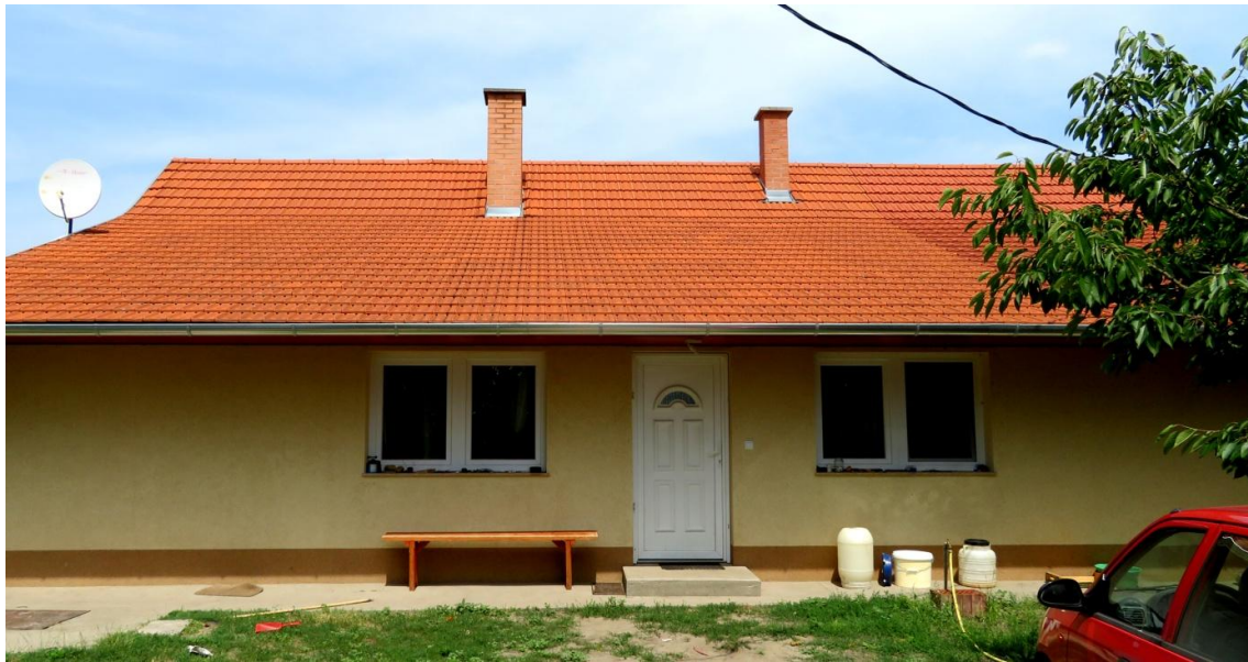
Ahol van villany, érdemes a régi lakóházat felújítani
