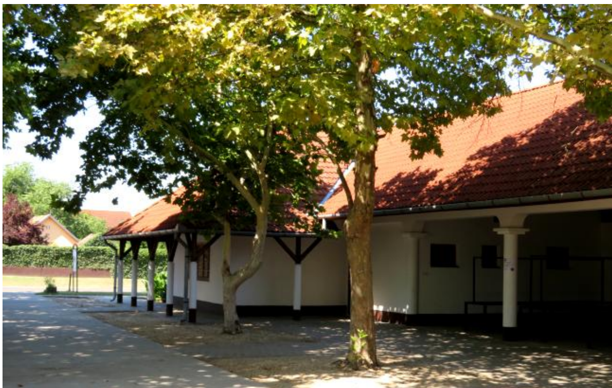
Piaccsarnok, homlokzati kép
