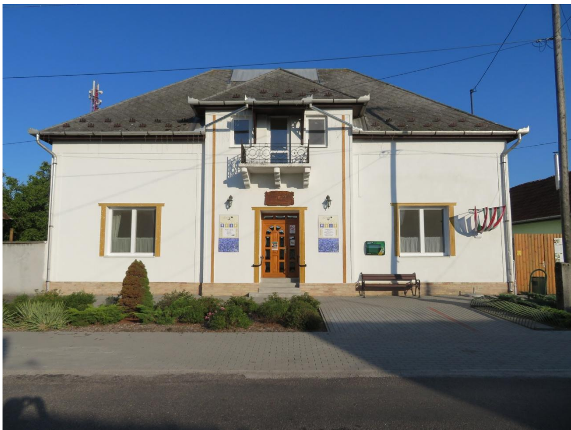
Az Ízek Háza Rákóczi Ferenc utcai homlokzata
