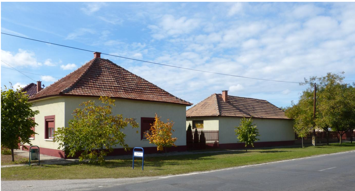
Utcavonalra telepített melléképület
