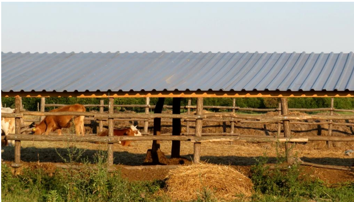
Az eternit hullámlemez sok helyen felváltotta az acél hullámlemez.
