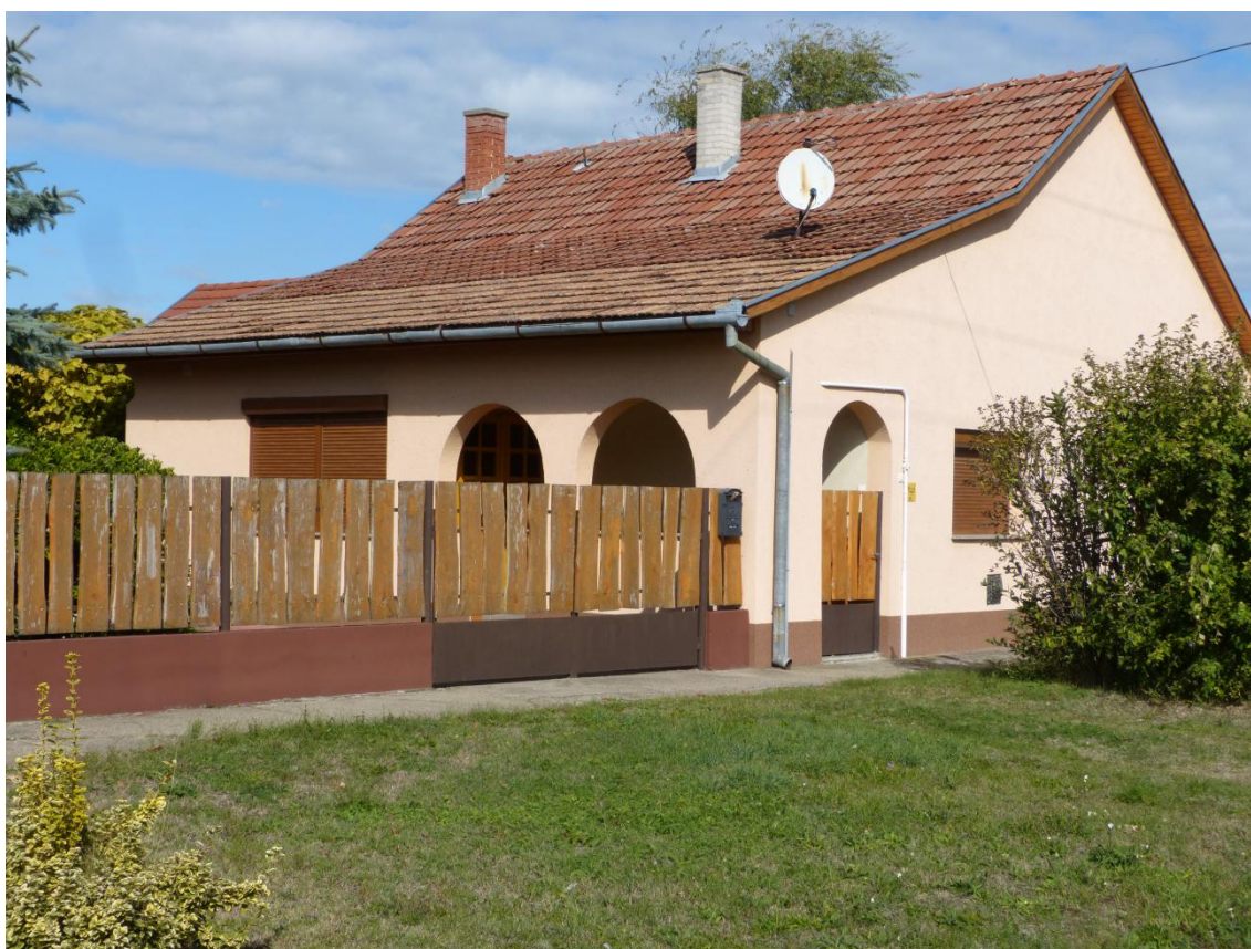
Szépen felújított toldott tornácos lakóépület, a tornác részleges beépítésével.
